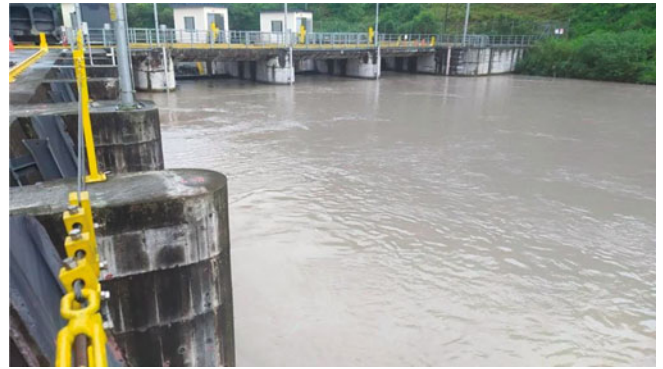
Рис. 2. Водозабор на речном стоке с наносами (слева сороудерживающие решетки на входе в отстойник)
