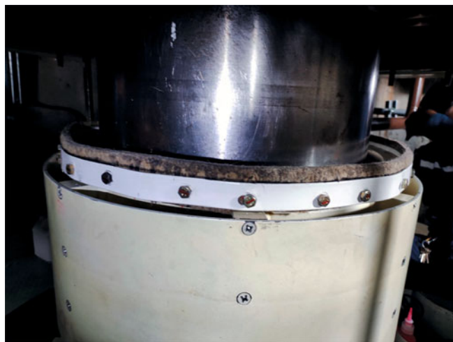
Рис. 12. Модернизированная выгородка масляной ванны нижнего генераторного подшипника
